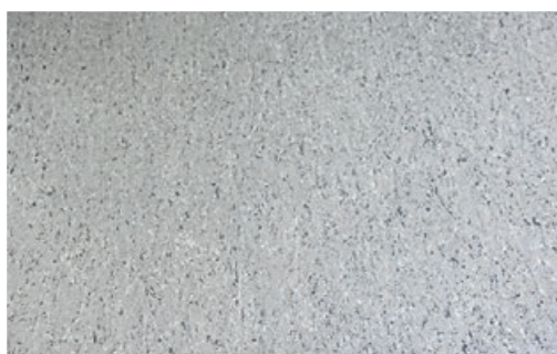
Износостойкое напольное покрытие
