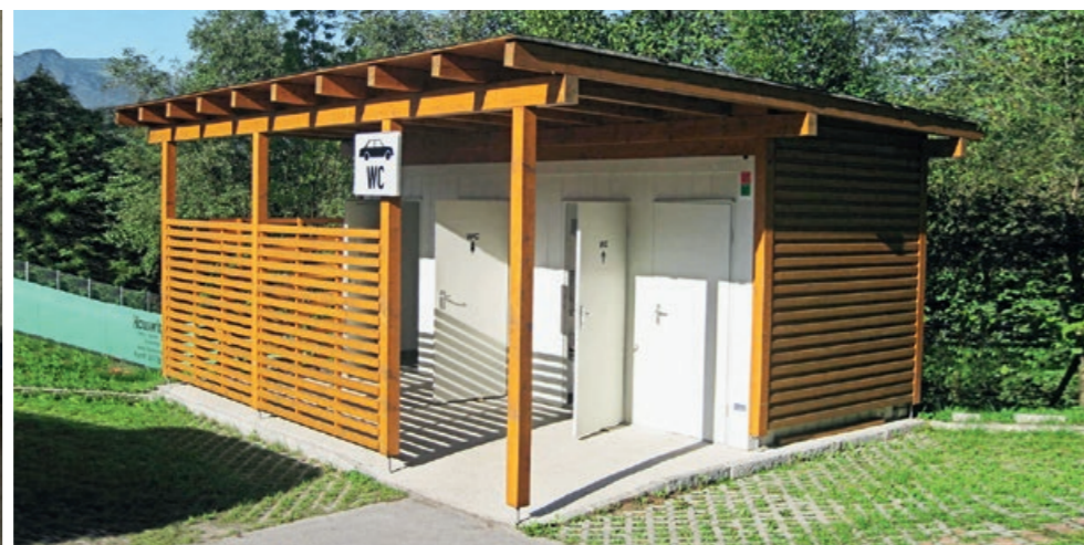
20-и футовый контейнер-туалет на стоянке
