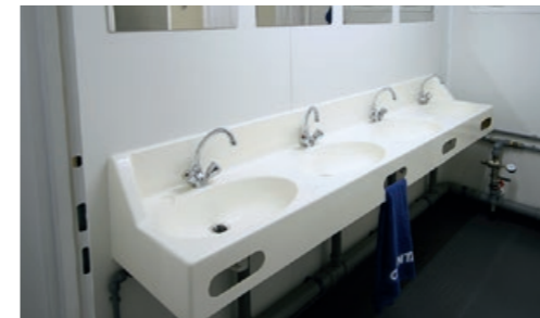
Лоток с двумя или четырьмя умывальными раковинами
