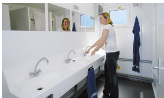
Санитарный блок-контейнер вид изнутри
