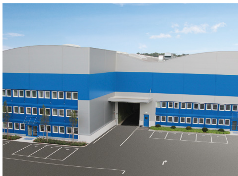
Офис на производстве
